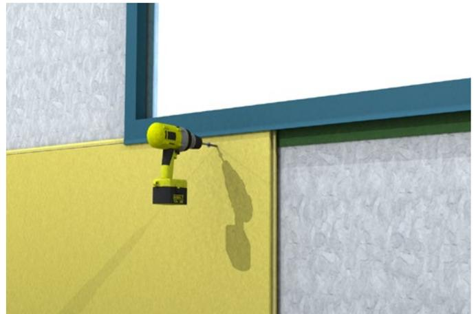
Fixation de face de la rive supérieure des panneaux aux appuis
